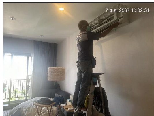
ภาพที่ 82 กิจกรรมล้างทำความสะอาดเครื่องปรับอากาศ ของอาคารชุด ชีวาทัย เรสซิเดนซ์ บางโพ
