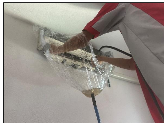
ภาพที่ 84 กิจกรรมล้างทำความสะอาดเครื่องปรับอากาศ ของอาคารชุดนภาพเลส
