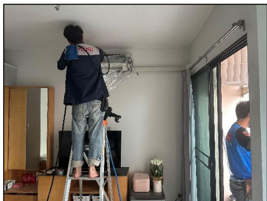
ภาพที่ 84 กิจกรรมล้างทำความสะอาดเครื่องปรับอากาศ ของอาคารชุดนภาพเลส
