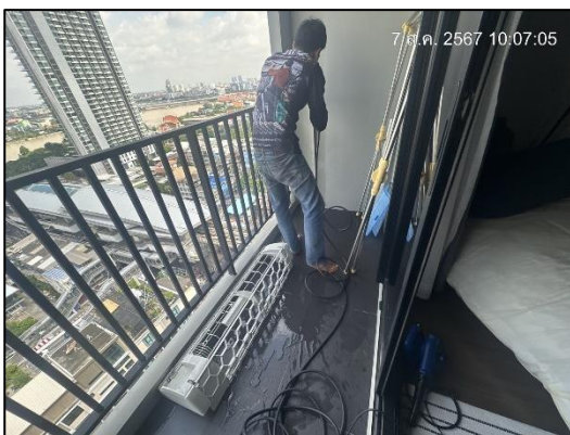
ภาพที่ 82 กิจกรรมล้างทำความสะอาดเครื่องปรับอากาศ ของอาคารชุด ชีวาทัย เรสซิเดนซ์ บางโพ
